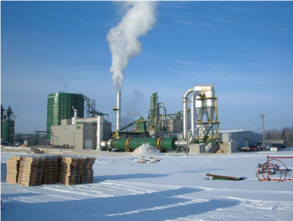
Figuur 9 Overzichtsfoto van een pelletfabriek
